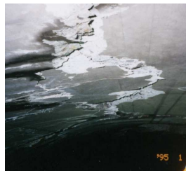
b) 軸圧縮力による せん断破壊
