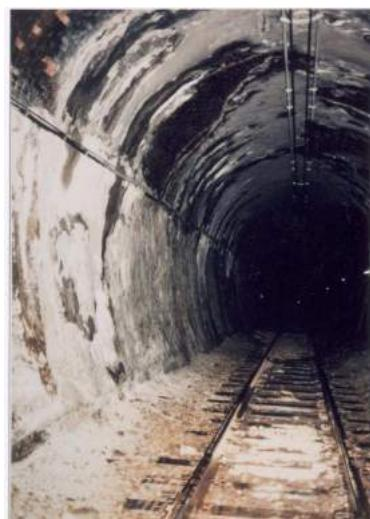
煉瓦トンネルにおける吹付けモルタルの剥落
